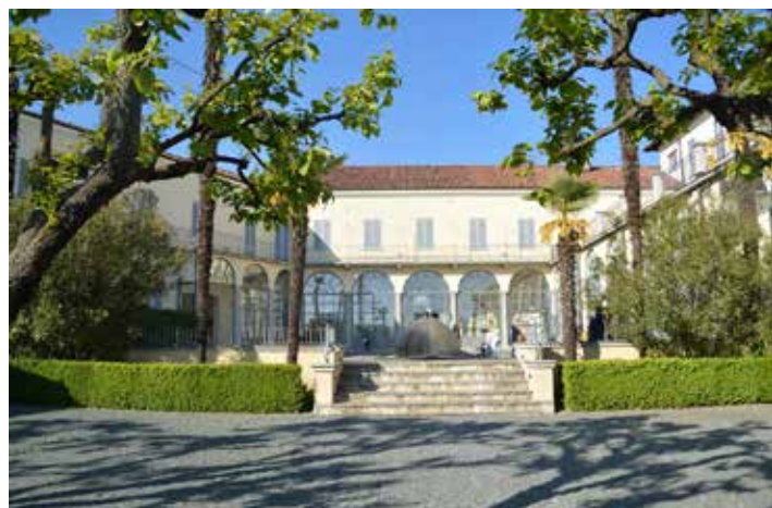
PALAZZO GROMO LOSA BIELLA
